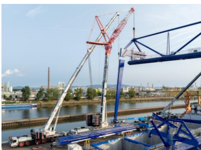
Bild 3: Kniffliger Hub des ersten Stützenträgers.
