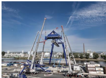
Bild 4: Clevere Krangestellung mit fünf Autokranen.
