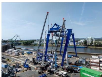
Bild 5: Umsetzen der Krane für eine effiziente Durchführung.
