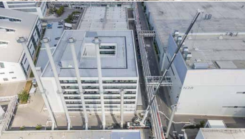
↑ **Verheben Segment 1: Der LTM 1230-5.1 hebt das untere Bauteil mit rund 16 Tonnen Gewicht und 28 Metern Länge an seinen Bestimmungsort. / ← Setzen Segment 1: Der Kranfahrer von BKL setzt das untere Bauteil an seinem Bestimmungsort. / ↘ Anheben Segment 2: BKL stellte den Kran dorthin, da die Kaminsegmente nur an einer bestimmten Position von den Lkw geladen werden konnten. / © BKL**
