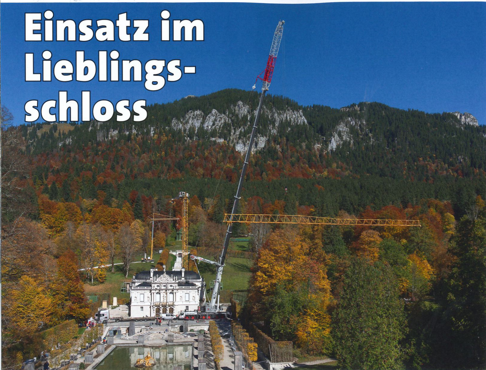
Mit dem LTM 1350-6.1 baut das BKL-Team den 90 EC-B nach gut zwei Jahren Einsatzzeit ab.
