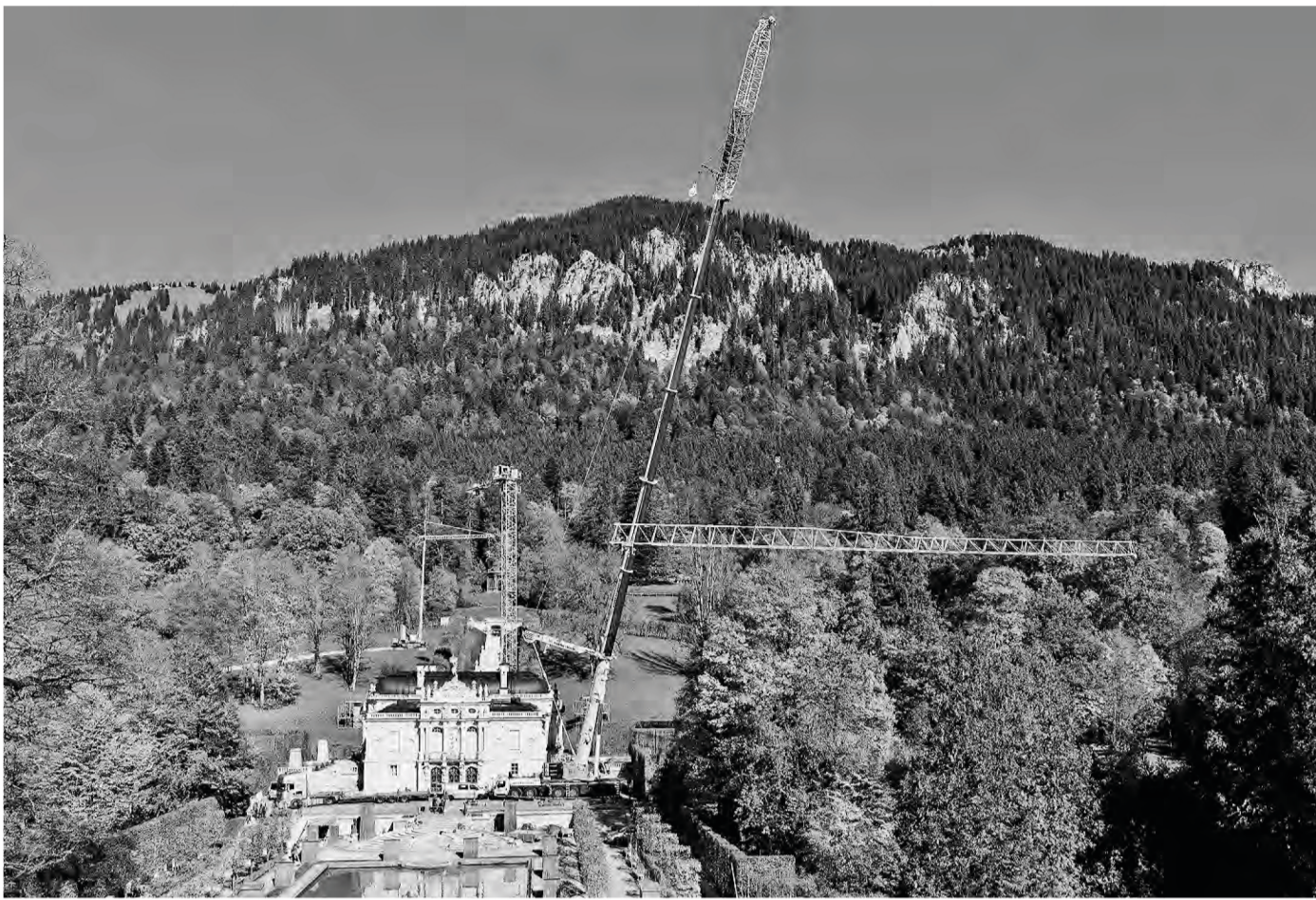
Der LTM 1350-6.1 hebt den 50-Meter-Ausleger des 90 EC-B über das Schloss hinweg. Als Hilfskran setzten die Autokranspezialisten von BKL einen ihrer 85-Metertonnen-Ladekrane ein. Am Hang hinter dem Schloss steht der 32 TTR mit Raupenfahrwerk.
