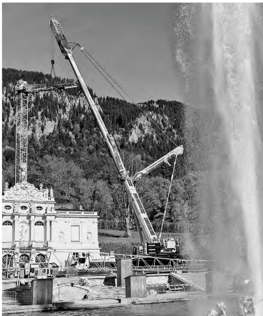
Der Ausleger des 90 EC-B ist bereits unten. Der LTM 1350-6.1 hat nun den Gegenausleger des Obendrehers am Haken.
