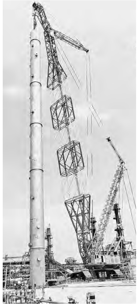
Die größte Herausforderung bestand darin, die gewaltige Stahlkonstruktion kontrolliert aus der horizontalen Lage im Tailingbetrieb in die vertikale Lage am Haken des Demag CC 8800-1 zu bringen. FOTO: DEMAG
